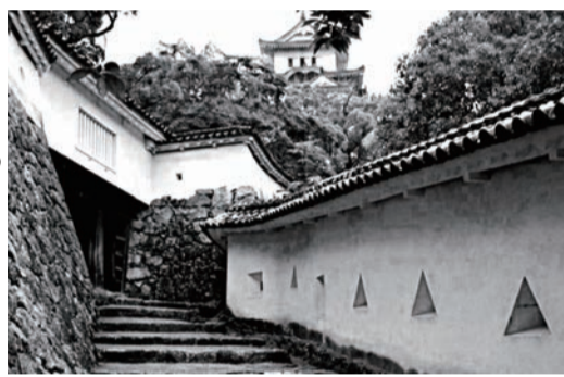
図8 水一門 ▶ 大天守に行く最後の門の一つ。敵からみると、この門は右斜め後ろにあるため死角となり、さらに門の向こう側が下るように造られているので大天守に通じると分らなくなっています。
