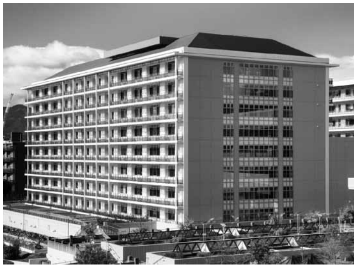
体内時計に依りて光を朝・昼・夜で自動調整する照明も備えた新病棟
