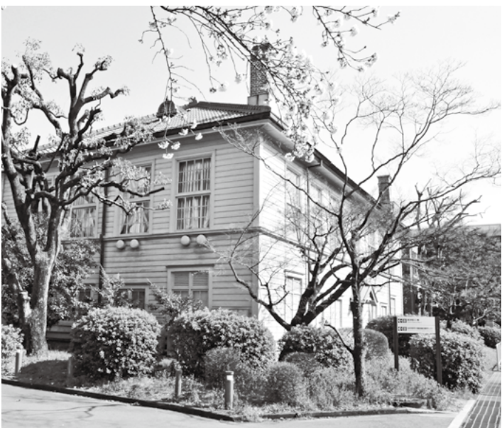
基礎医学記念講堂・医学部資料館は、京都帝国大学の解剖学教室講堂として1902年に竣工された。がん免疫総合研究センター棟は資料館の東側に建設中。新旧の建物が入り混じる医学部構内は、医学の歴史をものがたっている
